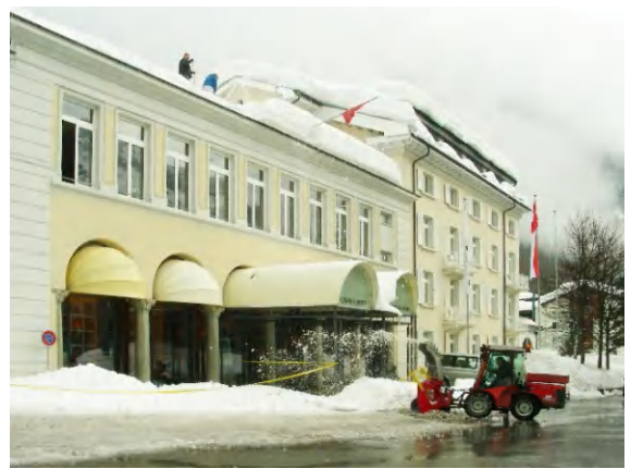
Zu viel Schnee für dieses Dach
